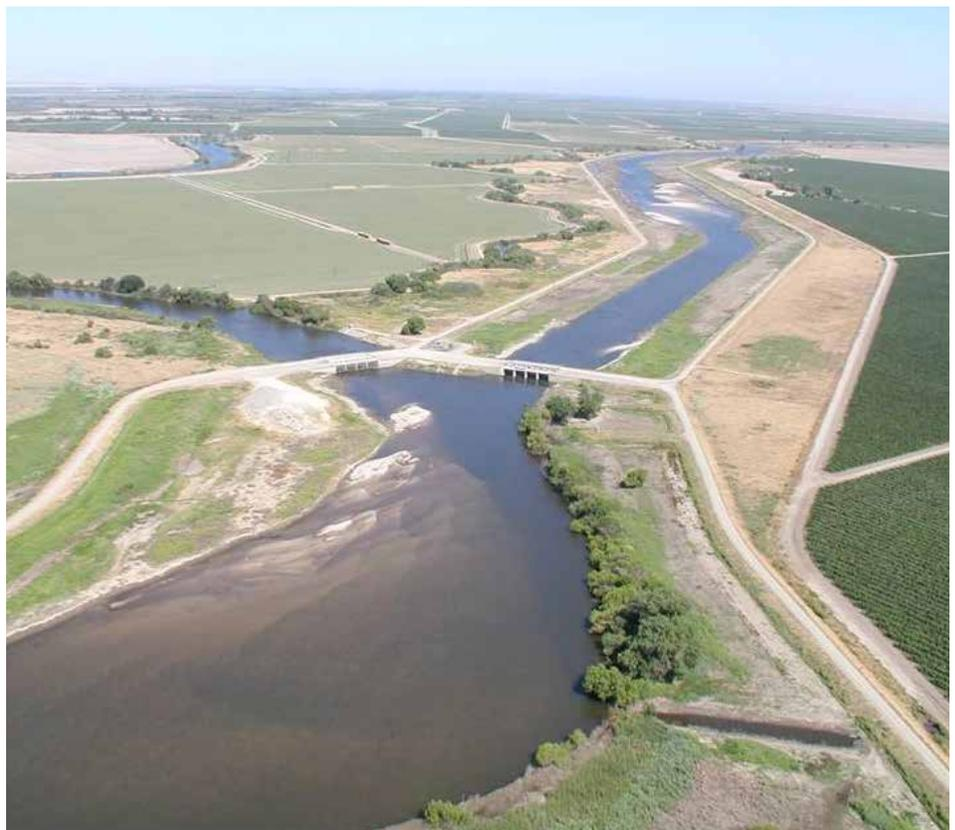
THE FLOOD CONTROL SYSTEM CONTROLLED BY THE SAN JOAQUIN RIVER BIFURCATION STRUCTURE UPSTREAM OF THE MENDOTA POOL IS BEING IMPACTED BY CURRENT SUBSIDENCE PROBLEMS.
